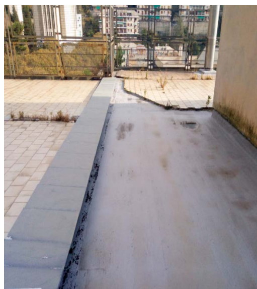
Figura 4.2 - Particolare della copertura
