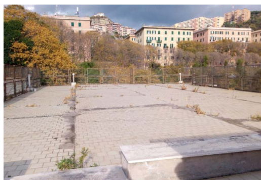
Figura 8.1 - Particolare copertura piana su cui intervenire.
