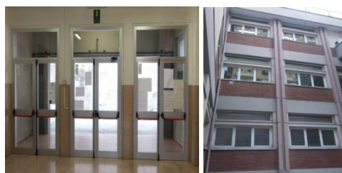
Figura 8.5 - Particolari dei serramenti da sostituire.
