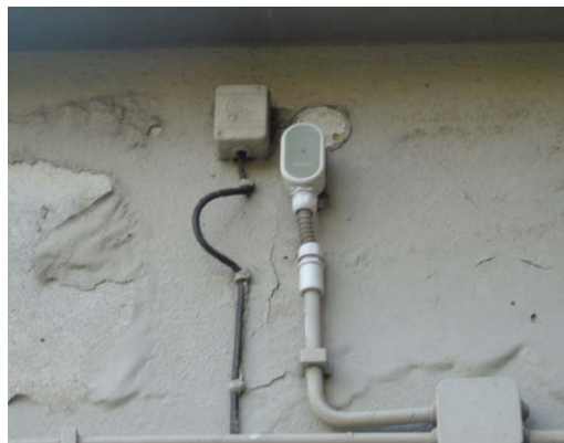
Figura 4.8 – Sonda climatica esterna
